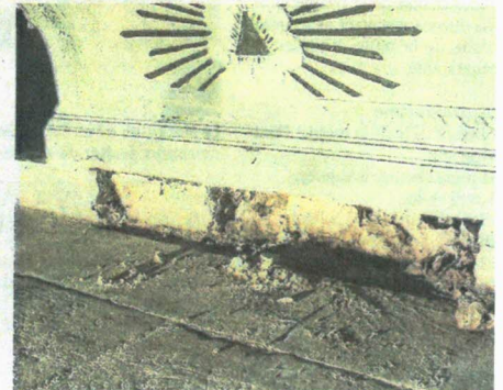
Les marches de l'autel ont été retirées sans dommage car le mortier est constitué de chaux et de sable local.
